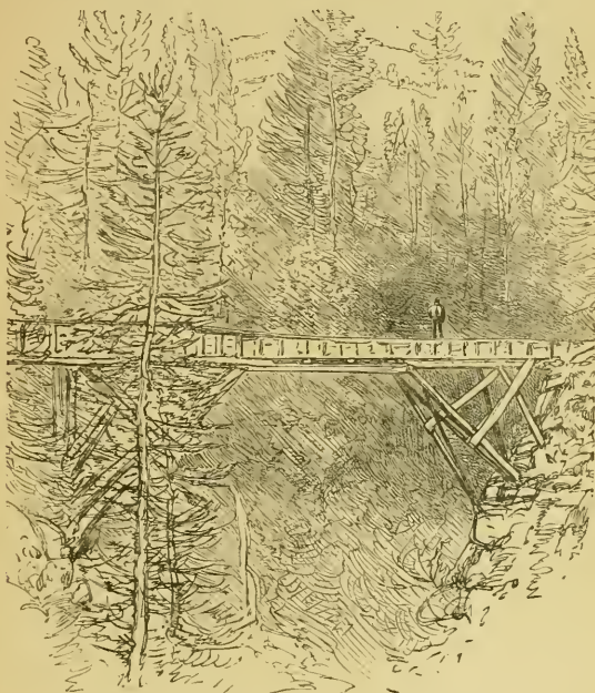
FIG. 81. — PONT-AQUEDUC SUR LE TORRENT ALBANISCA
